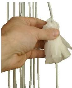
Äußerliches Reinigen der Leitungen
